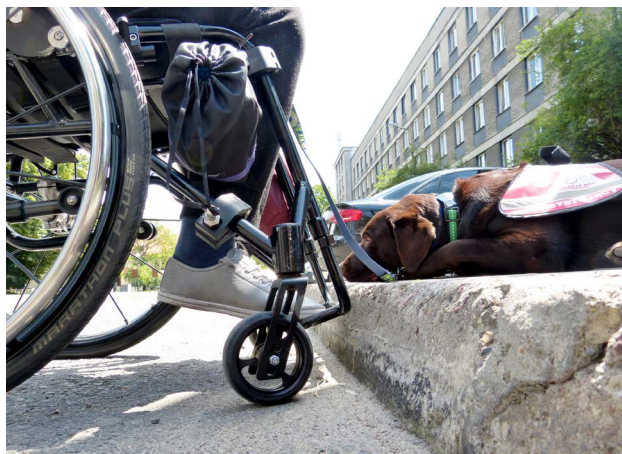
Fot. 13. Typowy stary krawężnik wewnątrz kwartału ulic. Nie do pokonania na wózku.
