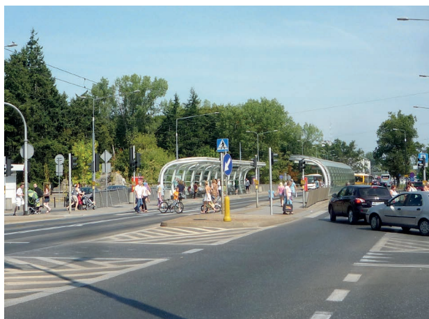
Fot. 44. Wspólny przystanek autobusowo-tramwajowy pozwala racjonalnie wykorzystać przekrój pasa drogowego.
