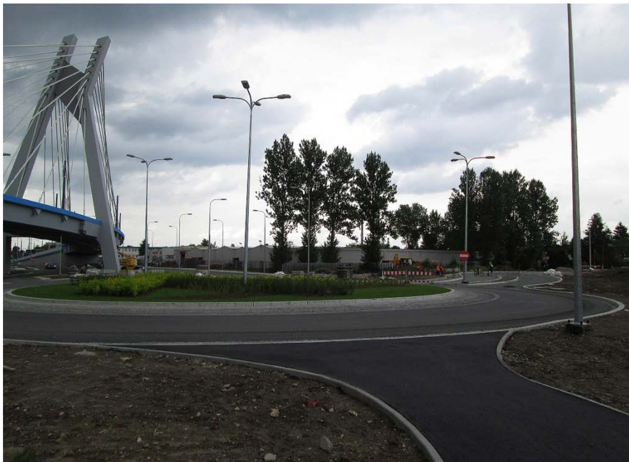
Fot. 43. Droga dla rowerów sprowadzana na poziom gruntu z estakady rowerowo-pieszo-tramwajowej nad stacją kolejową Kraków Płaszów zostaje wprowadzana w jezdnię ronda jako jego samodzielny wlot.
