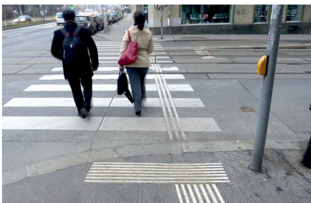
Fot. 20. Przejście z krawężnikiem 0 cm w Wiedniu dostosowane do potrzeb niewidomych. Karbowana ścieżka sygnalizuje drogę w sposób stały i niezaburzony, dlatego w tym rozwiązaniu nawet nieznaczna zmiana układu czy kierunku faktury jest łatwo wyczuwalna jako granica strefy bezpiecznej.
