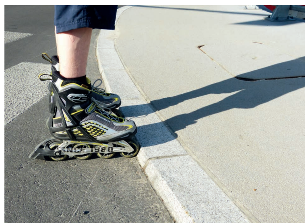
Fot. 16. Nowy krawężnik obniżony, ale wystający więcej niż 2 cm. Wymaga od rolkarza wykonania dodatkowego manewru.
