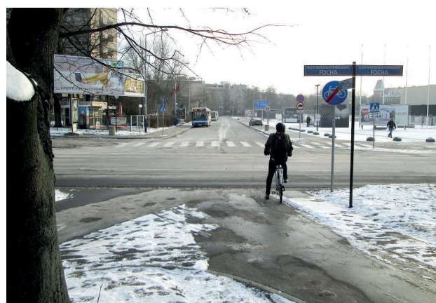
Fot. 39. Skrzyżowanie ul. Kałuży z al. generała Focha, widok z czwartego wlotu w stronę ul. Kałuży. Znak „koniec drogi dla rowerów” połączony z brakiem przejazdu dla rowerzystów przez jezdnię al. Focha oznacza, że rowerzyści w tym miejscu włączają się do ruchu, zatem ustępują pierwszeństwa pozostałym kierującym.
