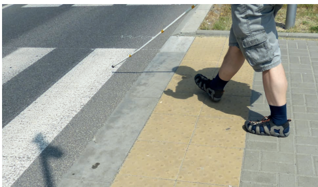
Fot. 17. Krawężnik 0 cm bez różnicy poziomów i z typowym pasem “guzów”. Niewidomy może wejść na jezdnię zanim zauważy zmianę nawierzchni.
