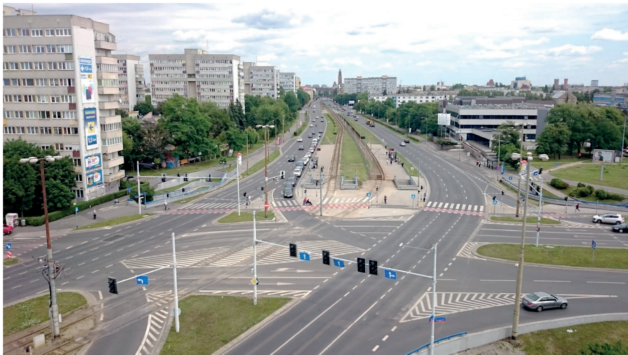
Fot. 24. Nowo otwarte przejście umożliwia szybkie przedostanie się na drugą stronę pieszym i rowerzystom.
