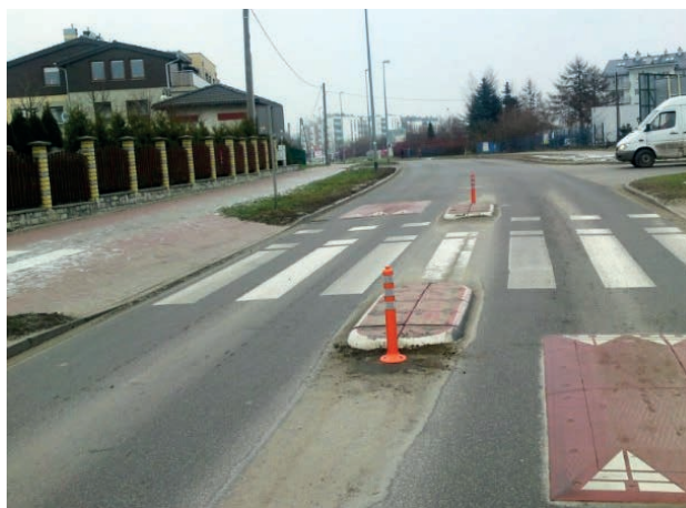
Fot. 10. Montaż progów wyspowych bezpośrednio przed azylami dla pieszych na ulicy Myśliwskiej uniemożliwia niebezpieczne zachowanie ze strony kierowców (próby ominięcia progów).
