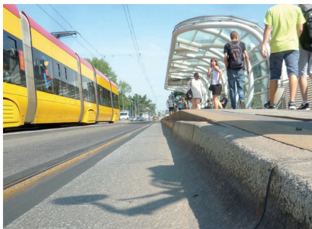
Fot. 45. Krawężnik przystankowy z zaokrągleniem umożliwia autobusom podjechanie do krawędzi peronu.
