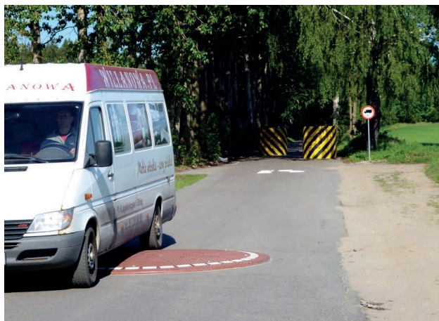
Fot. 9. Kompleksowe uspokojenie ruchu na ulicy Bysewskiej: na pierwszym planie próg wyspowy, na drugim – szykany.
