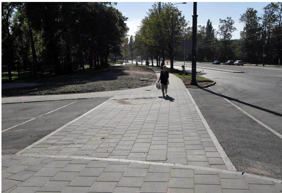
Fot. 12. Zachowanie ciągłości nawierzchni i niwelety (wysokości) chodnika (tzw. chodnik przechodni) przy ul. Lenartowicza w Gdańsku wyraźnie wskazuje granicę strefy ruchu uspokojonego.
