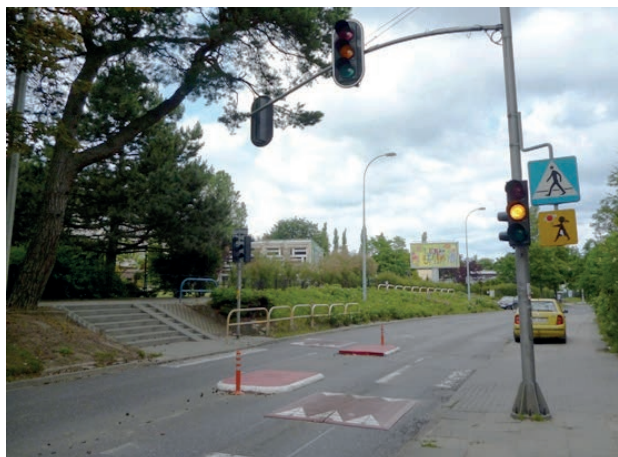
Fot. 8. Uspokojenie ruchu na ulicy Czyżewskiego skróciło czas oczekiwania pieszych, umożliwiając wyłączenie sygnalizacji świetlnej (na zdjęciu włączony jest tryb pulsujący).
