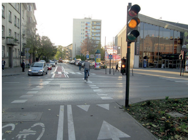
Fot. 42. Skrzyżowanie ul. Dunin-Wąsowicza z al. Krasińskiego, widok w kierunku ul. Dunin-Wąsowicza. Zwraca uwagę trójkomorowy sygnalizator, oznakowanie poziome drogi dla rowerów (linia warunkowego zatrzymania) i znak strefy „Tempo 30” (w głębi).
