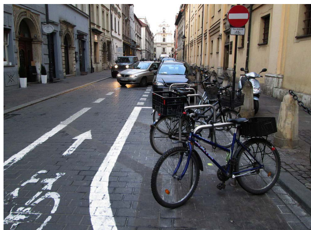
Fot. 36. Ulica św. Jana, skrzyżowanie z ul. Św. Tomasza. Stojaki wzdłuż kontrapasa wyeliminowały parkowanie uniemożliwiające obserwację nadjeżdżających samochodów (jest to skrzyżowanie dróg równorzędnych, obowiązuje „zasada prawej ręki”).
