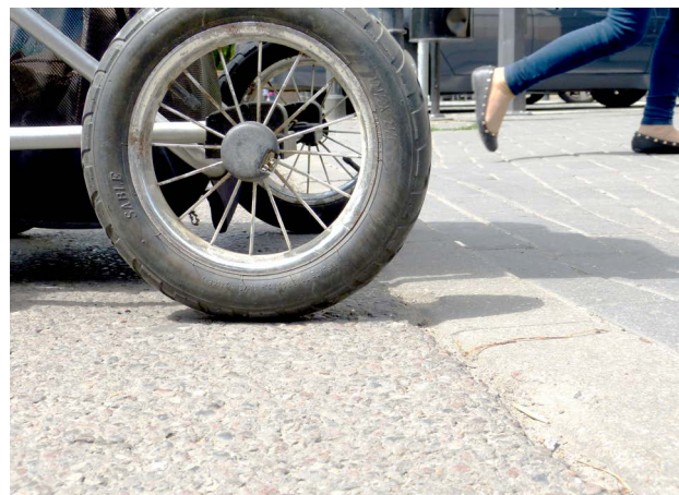
Fot. 14. Krawężnik 0 cm całkowicie niezauważalny dla rodzica z wózkiem.
