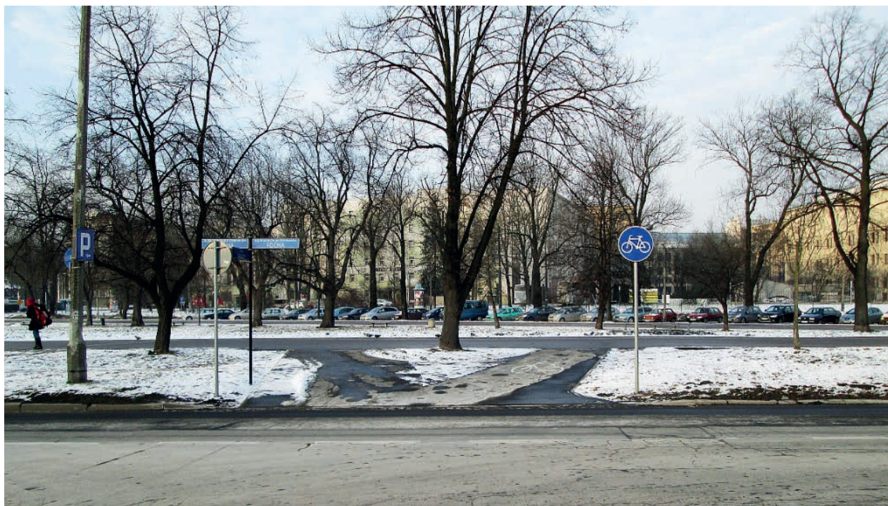
Fot. 40. Skrzyżowanie ul. Kałuży z al. generała Focha, widok drogi dla rowerów stanowiącej samodzielny, czwarty wlot skrzyżowania. Droga dla rowerów biegnie w poprzek zdjęcia w tle. Geometria czwartego wlotu została dostosowana do rosnącego w tym miejscu drzewa.
