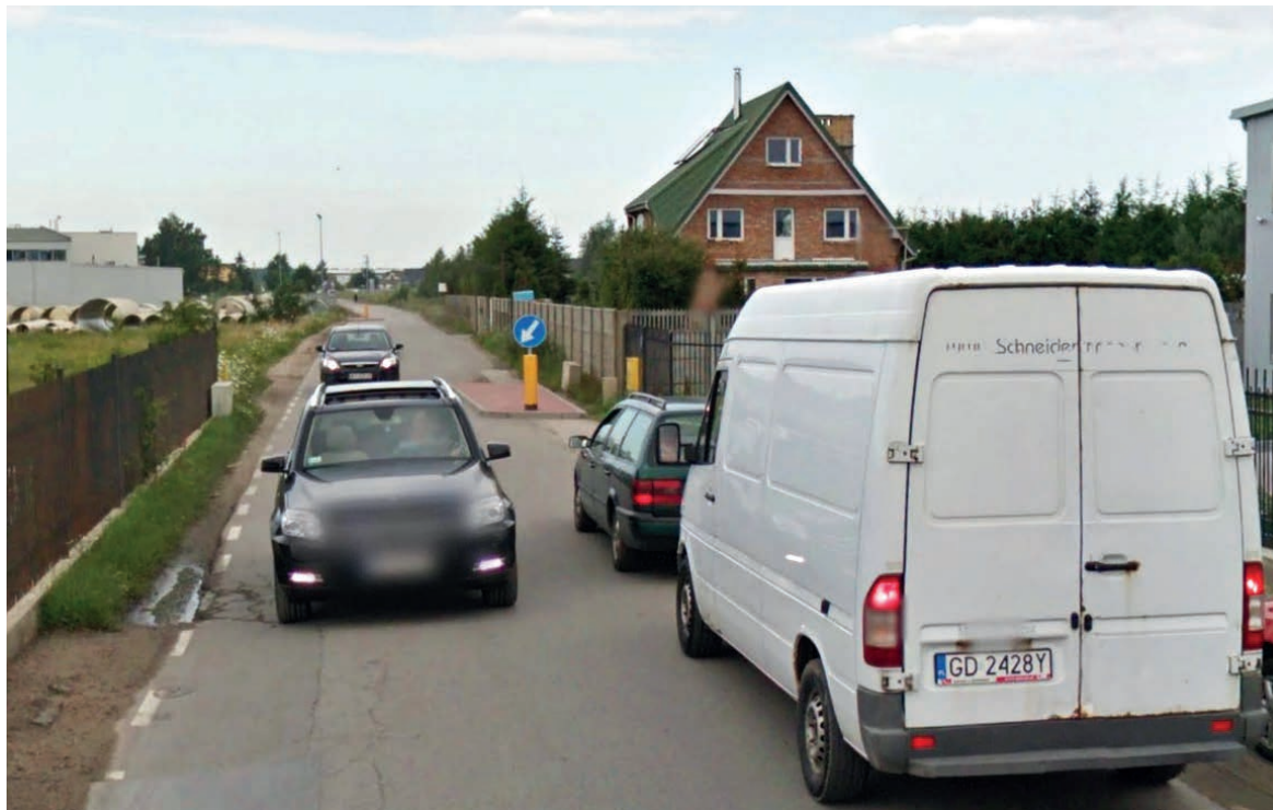
Fot. 11. Zwężenie jezdni na ul. Nowy Świat do szerokości jednego samochodu zmusza do ostrożnej jazdy, zwłaszcza gdy jest połączone z esowaniem toru jazdy (przy pomocy drugiej szyny w tle).
