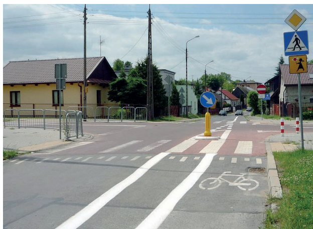
Fot. 30. Skrzyżowanie ul. Odrodzenia, Kaszubskiej i Górnej. Tarcza skrzyżowania została wyniesiona, a w ciągu kontrapasa zastosowano kostkę niezafazowaną.
