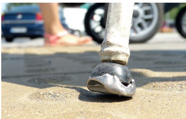
Fot. 19. Porównanie rozmiarów guza na płytach sygnalizujących niewidomym brzeg przejścia z końcówką białej laski. Guzy bywają mniejsze i większe. Lepiej sprawdzają się większe, ale i tak łatwiej je wyczuć pod butem niż laską.
