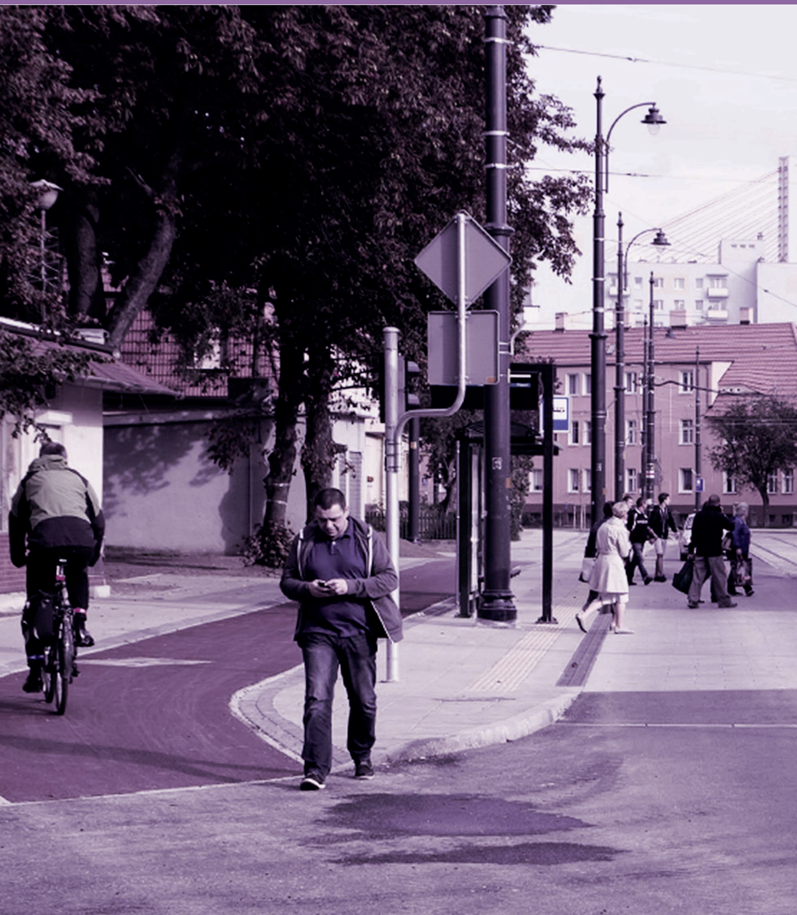
Ulica Lenartowicza w Gdańsku po przebudowie w 2015 r.
