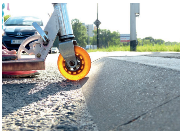
Fot. 15. Krawężnik "łamany" tylko teoretycznie umożliwia wjazd. W praktyce trzeba go pokonywać jak przeszkodę. Nie zastąpi on łagodnego spadku chodnika.
