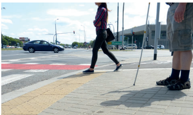
Fot. 18. Łagodny ale wyraźny spadek chodnika przed krawężnikiem 0 cm na długości paru kroków informuje niewidomego o zbliżaniu się do przejścia.
