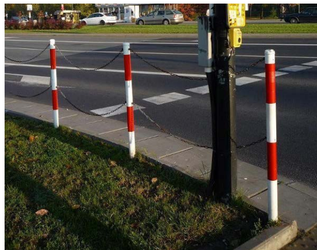
Fot. 31. Przycisk dla pieszych zamontowany w miejscu trudno dostępnym dla pieszych.
