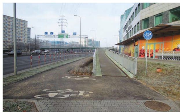
Fot. 8. Pochylnia umożliwiająca rowerzystom podjazd na kładkę nad ul. Rzymowskiego.
