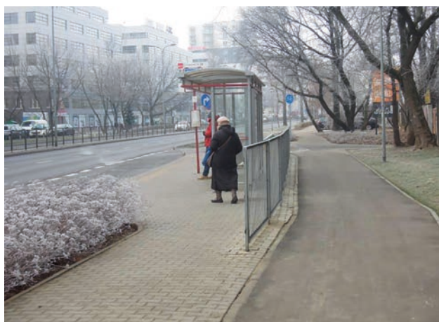
Fot. 12. Przystanek autobusowy wraz zatoką po północnej stronie ul. Cybernetyki.
