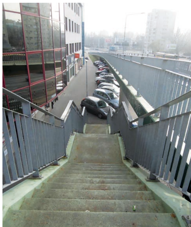
Fot. 7. Schody prowadzące na kładkę nad ul. Rzymowskiego.
