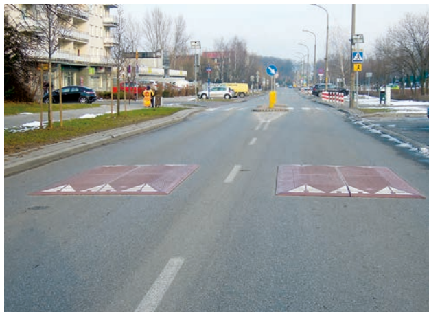
Fot. 38. Wyspowa progi zwalniające przy wyposażonym w wyspę przejściu dla pieszych na ul. Przy Bażantarni.
