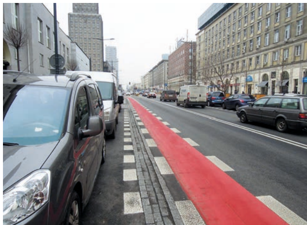
Fot. 18. Ulica Świętokrzyska po remoncie.
