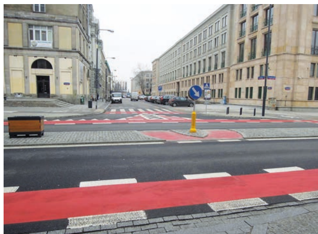
Fot. 21. Przepusty umożliwiające rowerzystom lewo-skręty na skrzyżowaniu z ul. Czackiego.
