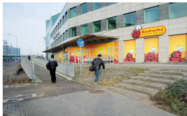
Fot. 9. Pochylnia umożliwiająca rowerzystom podjazd na kładkę nad ul. Rzymowskiego.
