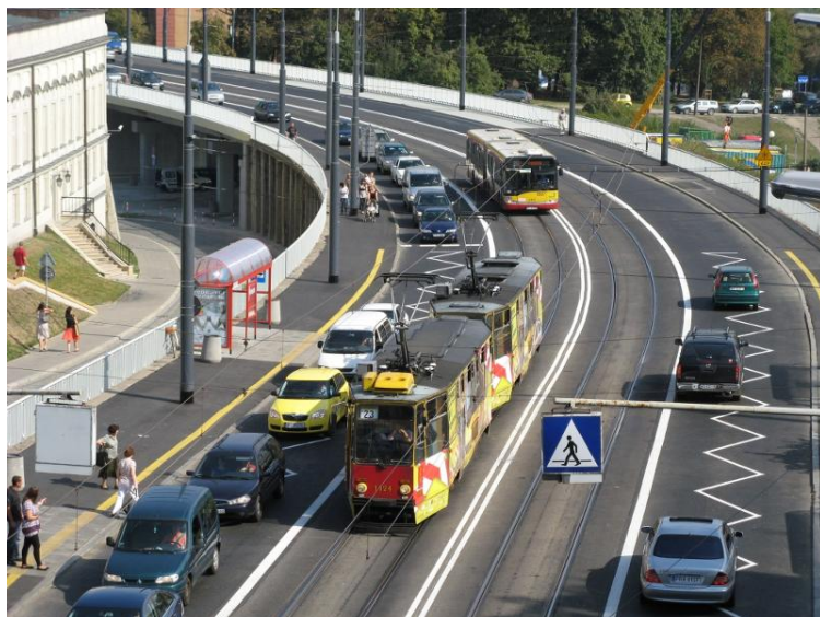
Torowisko tramwajowo-autobusowe na trasie W-Z
