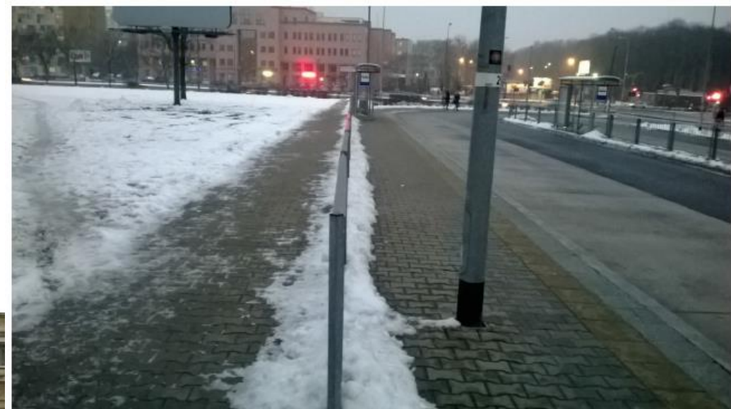
Zbędne bariery utrudniające poruszanie się
