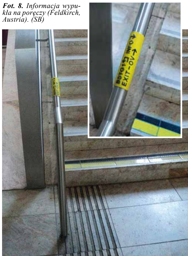
Fot. 9. Ścieżka dotykowa naprowadza na poręcz schodów na której umieszczono informację wypukłą. W tym przypadku przed schodami pas ostrzegawczy oznakowania dotykowego jest niepotrzebny (Feldkirch, Austria). (SB)
