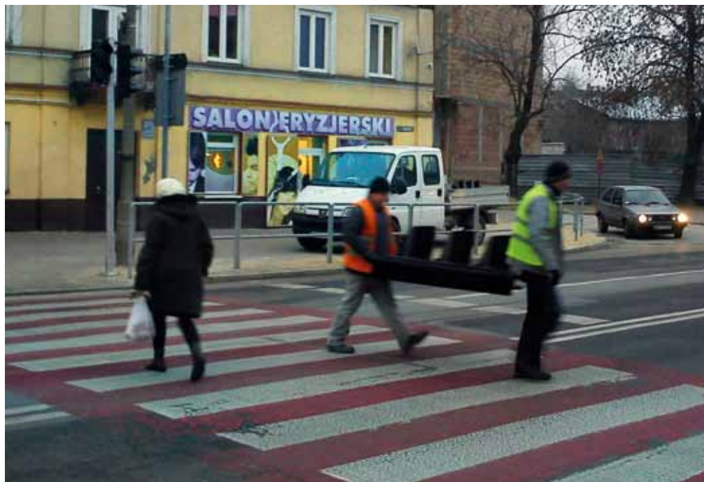
Fot. 1. Długo oczekiwany montaż sygnalizacji. Prędko, Panowie! Przejście jest niebezpieczne! (SP)
