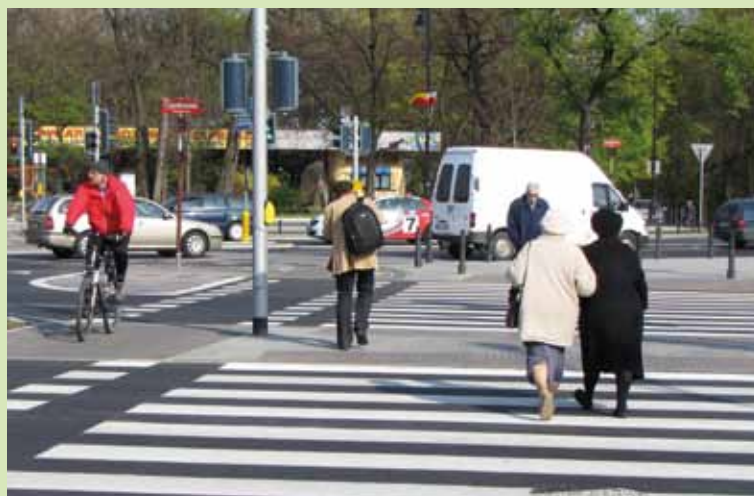
Fot. 4. Wyznaczenie przejścia naziemnego zapewniło możliwość legalnego pokonania ulicy osobom starszym i mniej sprawnym. (AB)
