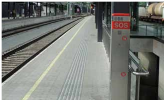
Fot. 4. Pas ostrzegawczy na peronie będący jednocześnie ścieżką prowadzącą – standard m.in. w Niemczech i Austrii (na zdjęciu Feldkirch, Austria). (SB)
