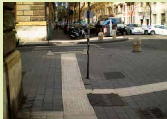
Fot. 15. Oznakowaniem dotykowym często objęta jest cała zabudowa śródmiejska, w wielu wypadkach ze skrzyżowania ścieżka doprowadza niewidomego do ściany, wzdłuż której może on się poruszać samodzielnie, tak samo ścieżki dotykowe nie są wymagane wzdłuż tuneli pieszych (Rzym). (KR)
