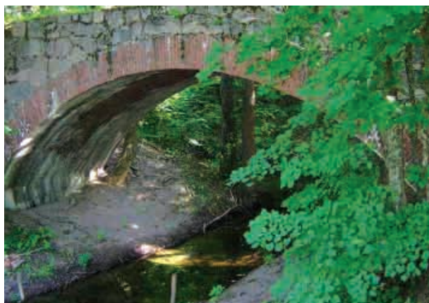
Most pokolejowy przy drodze Ukta - Piecki, nad strugą pomiędzy jeziorami Kołwin i Mokrem - pozostałość linii Ruciane - Mrągowo (MJ)
