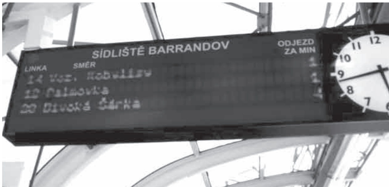
Na każdym z nowych przystanków znajduje się tablica świetlna informująca o trzech najbliższych tramwajach, ich pętlach docelowych oraz czasie, który pozostał do pojawienia się danego tramwaju na przystanku (AB)
