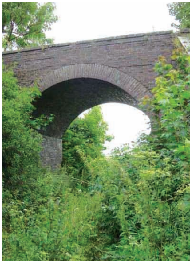
Wiadukt pokolejowy w pobliżu wsi Kwietniewo - pozostałość linii Myślice - Elbląg (MJ)
