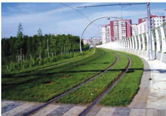
Torowisko zostało obsiane trawą, by wytłumić drgania. Dodatkowo od strony osiedla zainstalowane zostały ekrany dźwiękochłonne (AB)
