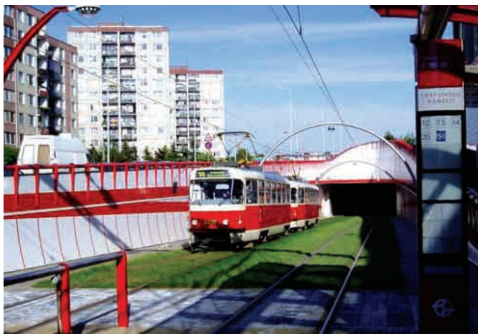
Tunel pomiędzy przystankami Poliklinika Barrandov i Chaplinovo náměstí (AB)
