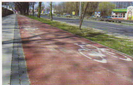
Dobra asfaltowa nawierzchnia dla rowerzystów z jednoznaczным oddzieleniem od chodnika
