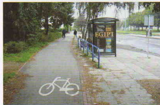
Bezpieczne ominięcie przystanku, barierki zapobiegają niespodziewanemu wyjściu pieszego.
