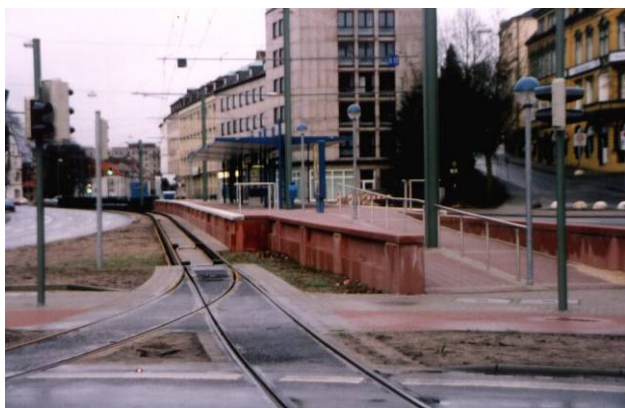
Bielefeld: przystanki tramwajowe są wysokie, gdyż w centrum tramwaje wjeżdżają w kilkukilometrowy tunel, do złudzenia przypominając metro. (KR)
